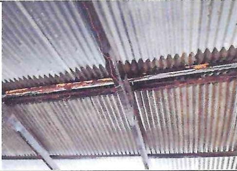
Foto 1: Techo dañado por la corrosión.
