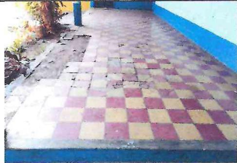
Foto 6: Piso del corredor deteriorado
