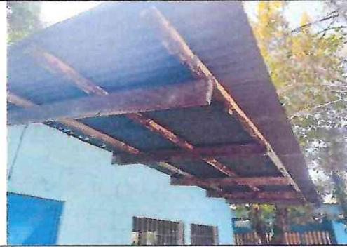
Foto 2: Estructura de madera dañana por humedad.
